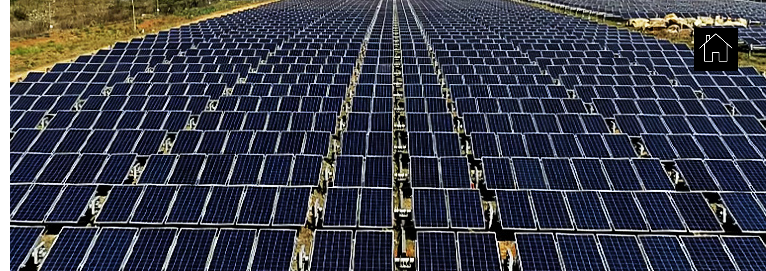
📷 Komatikuntla (K1) Solar Plant
